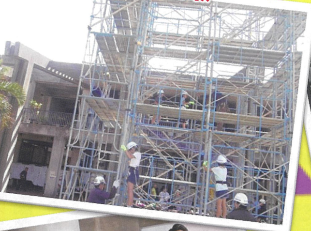
高所足場の体験
